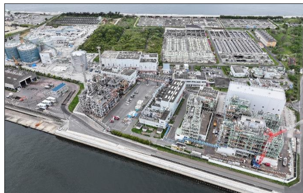
【兵庫東流域下水汚泥広域処理場】
